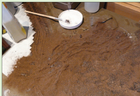
Rund um dem Betriebshof wird Torfbodenerde aufgebracht.
